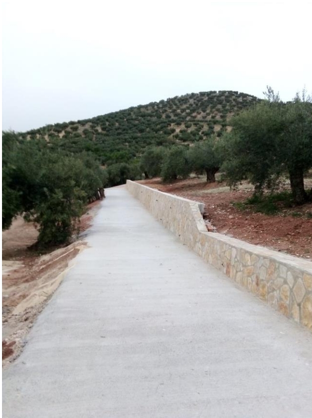
Obra del muro y carril
