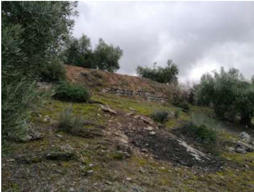
Fotografía 2: muro Norte en su estado original (antes de la actuación agrícola)
