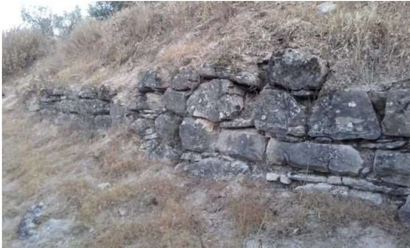
Fotografía 1: muro Norte en su estado original (antes de la actuación agrícola)
