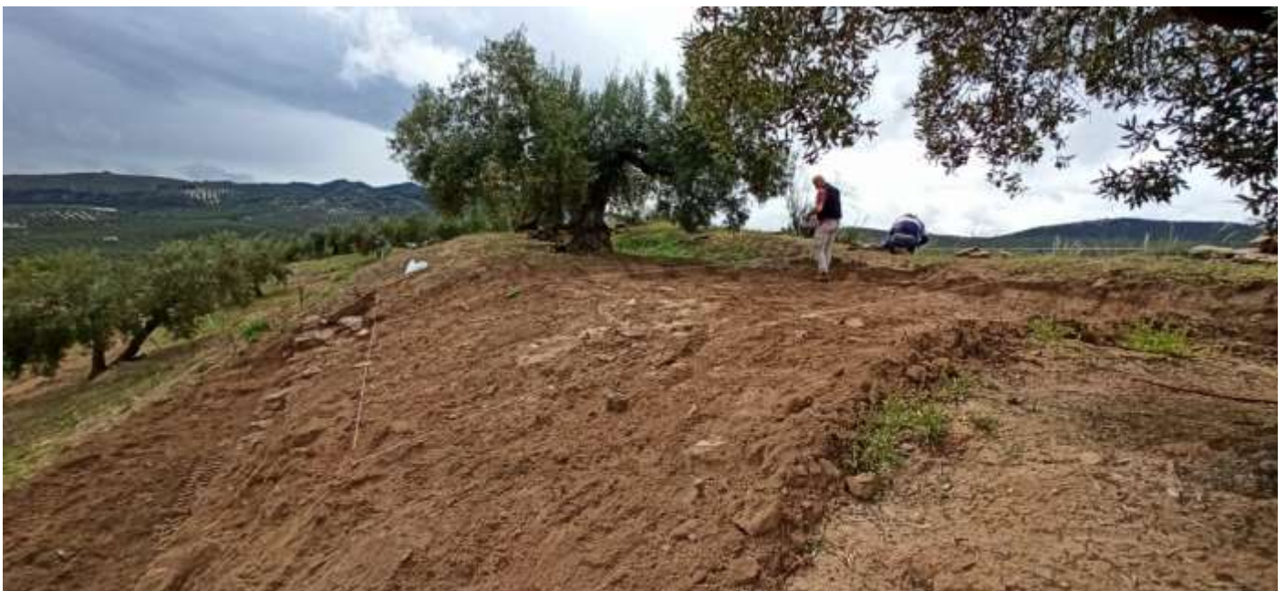
Fotografía 11. Delimitación de la zona de excavación
